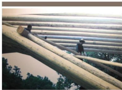
廊桥的建筑工艺流程：剪刀撑
