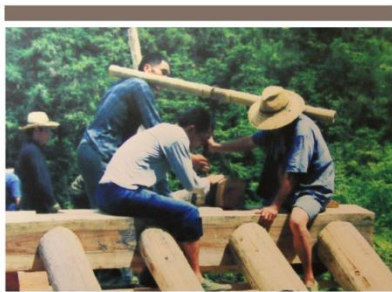
廊桥的建筑工艺流程：三节苗对接
