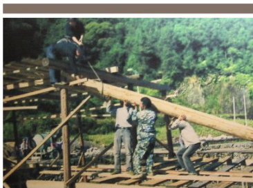
廊桥的建筑工艺流程：上三节苗
