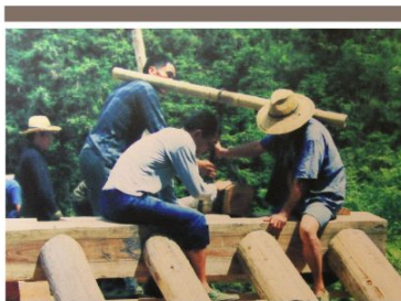
廊桥的建筑工艺流程：三节苗对接
